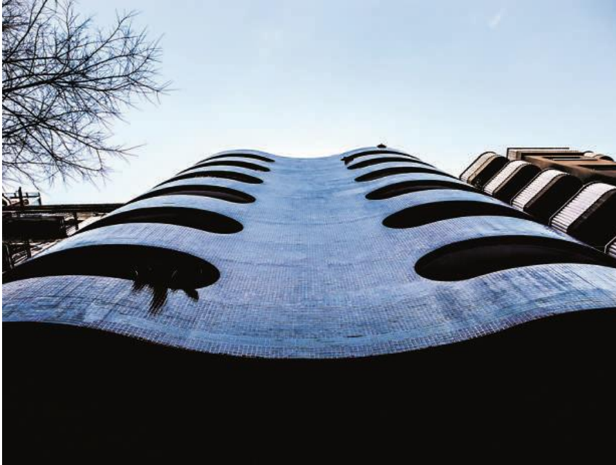
OFFICE BUILDING IN SAINT MARY CLARET STREET OFICINAS EN CALLE SANTA MARÍA CLARET (1975) MARIO CATALÁN NEBOT
